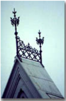
Toiture du presbytère de la paroisse Sainte-Cunégonde de Montréal, Photo : François Brault
