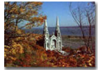
Vue d'ensemble su site Photo : François Brault
