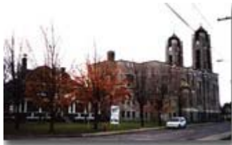
Élévation latérale extérieure Photo : CPRQ
