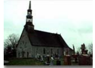
Ensemble extérieur vu du cimetière Photo : François Brault
