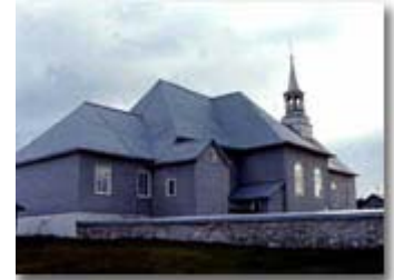
Extérieur du chœur et de la sacristie Photo : Germain Casavant
