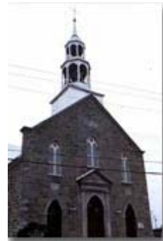
Façade après modifications Photo : Germain Casavant
