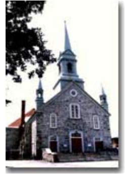
Façade Église de Beauceville Photo : Germain Casavant
