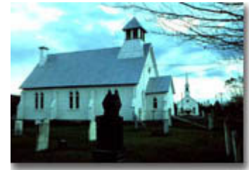
Église anglicane Kinnear's Mills Photo : François Brault
