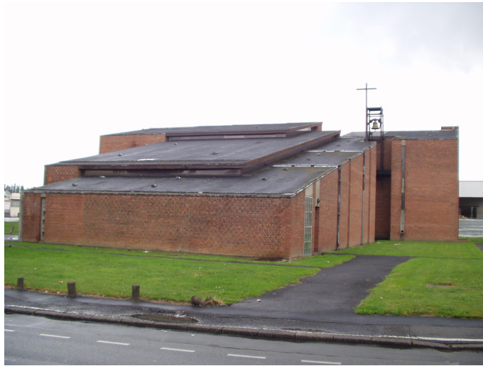
Fig. 19 - Église Notre-Dame-de-la-Paix, Tourcoing. Jean Willerval architecte, 1963-64. Vue extérieure. Phot. Céline Frémaux, 2002.
