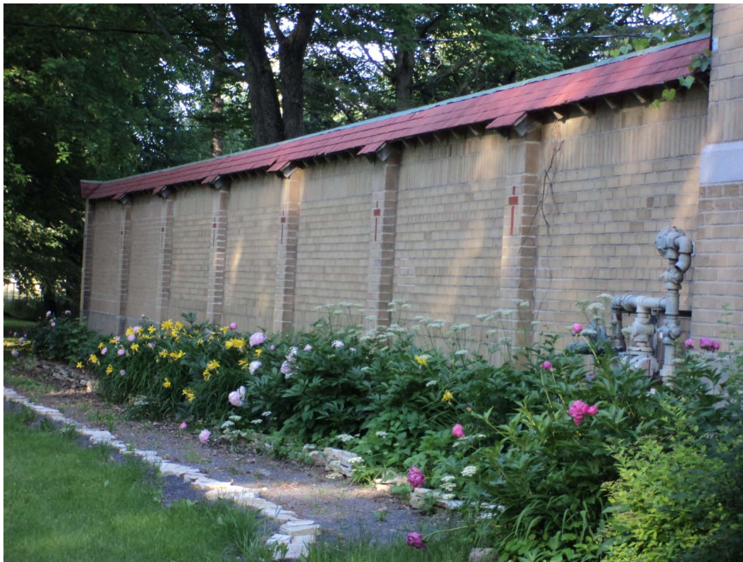
Mur d'enceinte, vu de l'extérieur
