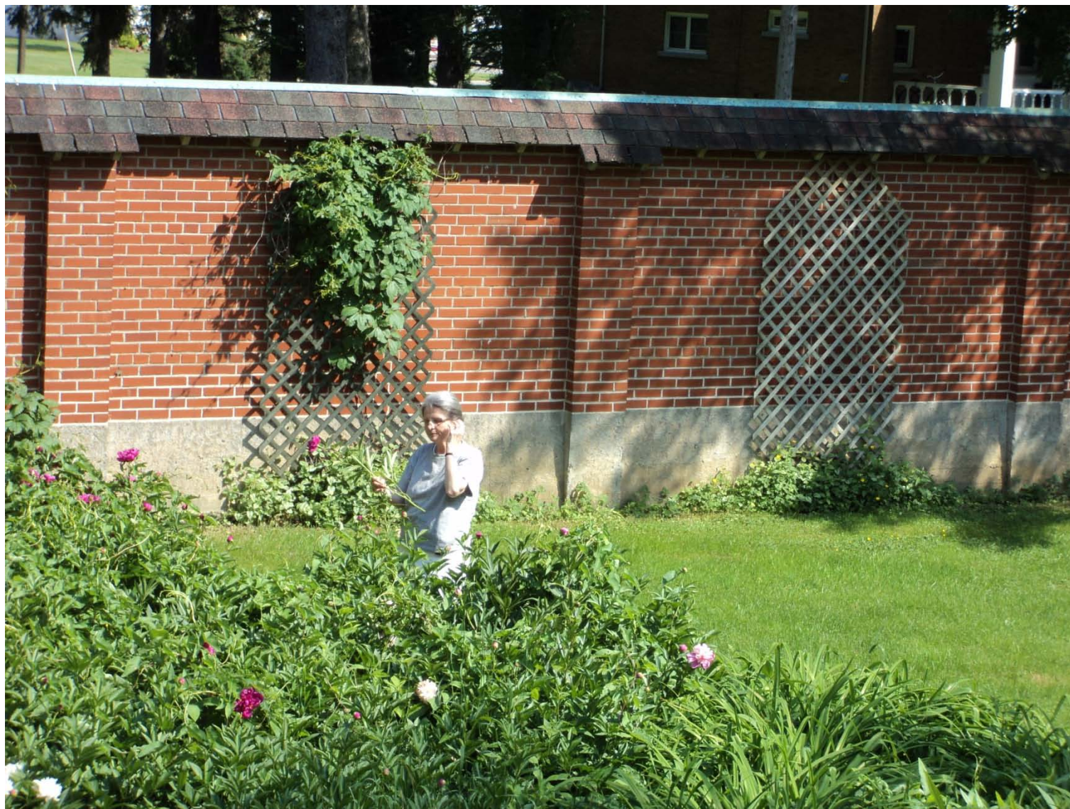
Mur d'enceinte, côté jardin
